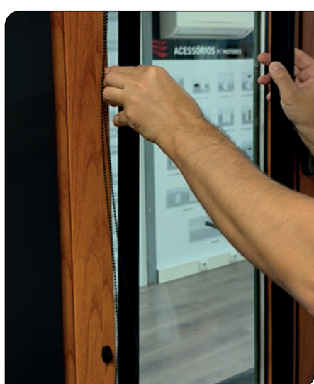
7. Com atenção, encaixar os perfis no bit da janela
