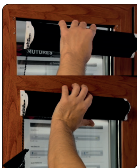
1. Encaixar a caixa no bit da janela
